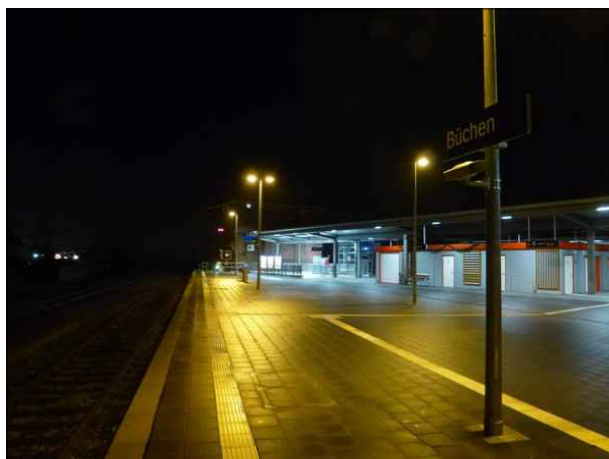
Abbildung 52: Das Bahnhofnamensschild an Gleis 140 in Büchen war ebenso unbeleuchtet wie die Schilder am neuen Bahnsteigdach.
