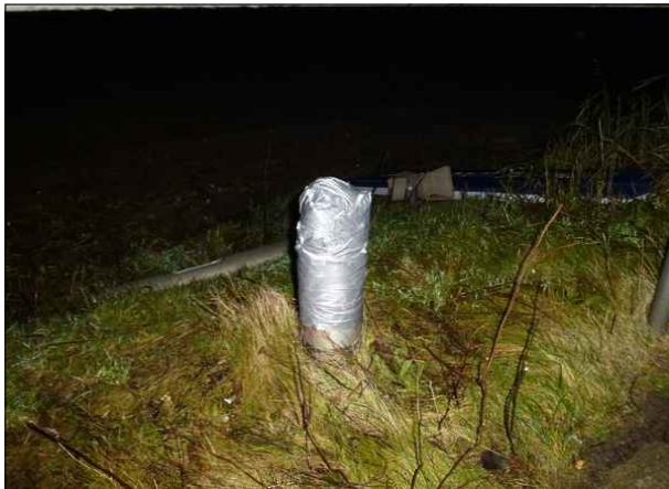
Abbildung 50: Ein Lichtmast der Bahnsteigbeleuchtung in Langenhorn an Gleis 2 war abgebrochen.
