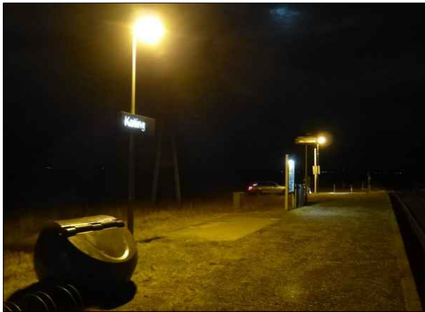
Abbildung 7: Der Fahrgastunterstand in Kating ist durch einen Orkan zerstört worden. Seit dem gibt es keinen Wetterschutz und keine Sitzgelegenheit mehr an dem Haltepunkt.
