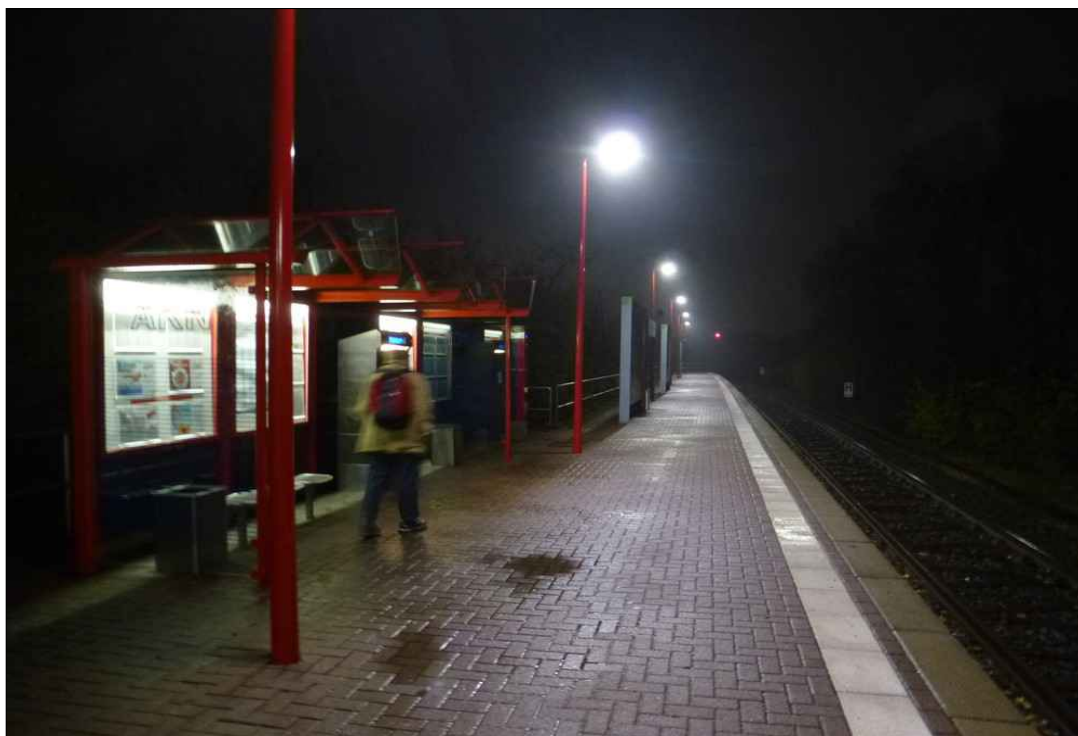
Holstentherme: Haltepunkt an der Strecke Kaltenkirchen - Neumünster.
