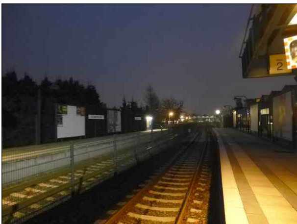
Abbildung 47: Außerhalb der Überdachungen war die Bahnsteigbeleuchtung in Friedrichsgabe defekt.
