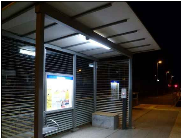
Abbildung 40: Der mutwillig zerstörte Automat in Kiel-Elmschenhagen war abgebaut. Leider fehlten Hinweise zum Fahrscheinerwerb, und auch der Entwerfer war defekt.
