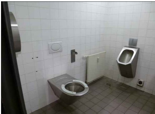
Abbildung 38: An der Herren-Toilette des Bahnhofs Lübeck-Travemünde Strand sind mittlerweile beide Haltebügel für mobilitätseingeschränkte Nutzer abgerissen.
