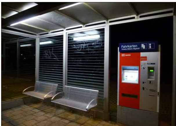
Abbildung 9: Nach wie vor ist der Bereich rund um den im Herbst 2011 eingebauten Fahrkartenautomaten in Felde nicht abgedichtet.
