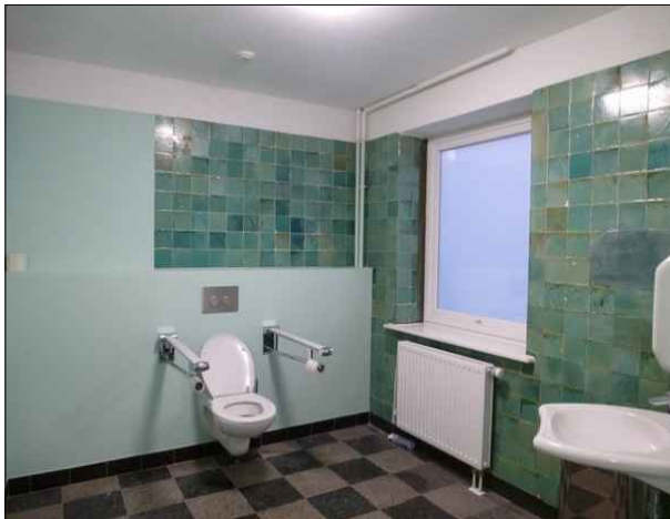
Abbildung 37: Im Bahnhofsgebäude von Keitum wurden in den seit Jahren ungenutzten Warteraum vom Bahnsteig aus zugängliche öffentliche Toiletten eingebaut.
