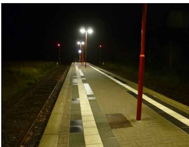
Abbildung 57: Die beschädigten Platten des Kontraststreifens auf dem Bahnsteig in Wiemersdorf sind ausgetauscht worden.
