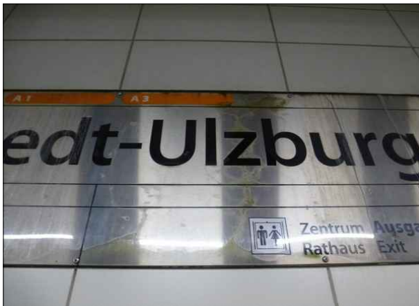
Abbildung 20: Hinter die Abdeckungen einiger Bahnhofnamensschilder in Henstedt-Ulzburg ist Wasser gelaufen, und es haben sich stellenweise Algen gebildet.
