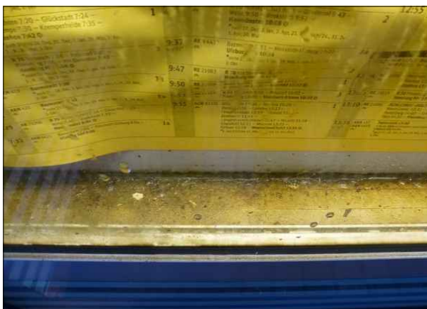
Abbildung 30: In der Vitrine des nördlichsten Fahrgastunterstands an Gleis 1 in Elmshorn hat sich zum wiederholten Mal Wasser gesammelt.
