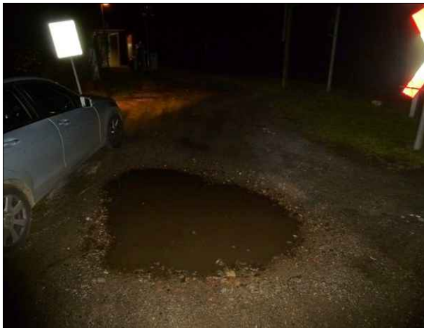
Abbildung 44: Die schon im letzten Sommer vorhandene tiefe Mulde im Zugang des Bahnsteigs in Witzwort ist nicht beseitigt worden und stand erneut voll Wasser.
