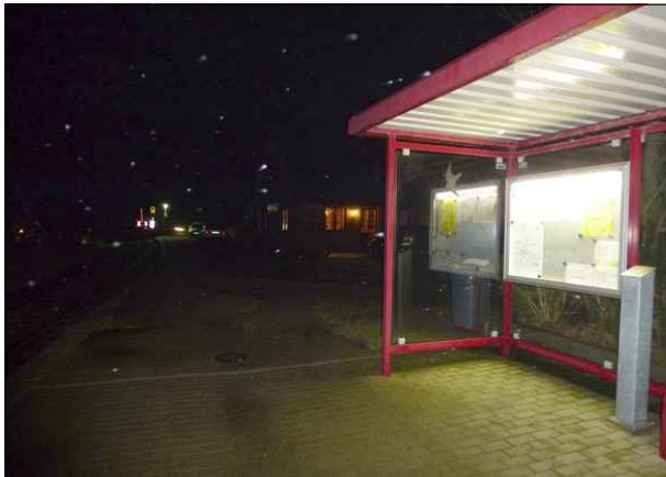
Abbildung 55: Der Bahnsteig in Maasbüll ist im mittleren Bereich weiterhin vollkommen unbeleuchtet.
