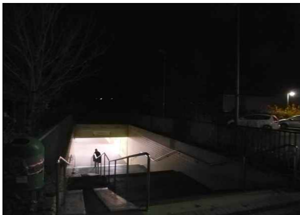
Abbildung 48: Die Treppe des Zugangs Ostereschweg am Bahnhof Halstenbek war unbeleuchtet, da beide Lichtmasten nicht funktionierten.
