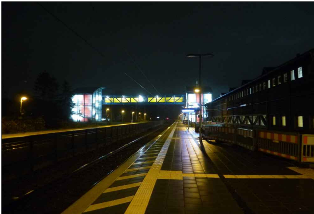
Tornesch: Bahnhof an der Strecke Hamburg - Elmshorn: Die im April 2013 begonnenen Bauarbeiten am Hausbahnsteig waren Ende November immer noch nicht abgeschlossen. Am nördlichen Ende waren die Beleuchtung und die Baustellenabsicherung unzureichend. Es bestand Stolper- und Absturzgefahr.
