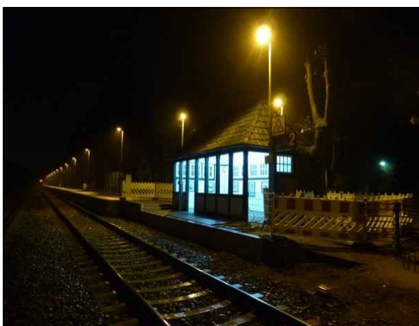
Abbildung 12: Auf den erneuerten Bahnsteigen in Prisdorf wurden noch keine Unterstände aufgebaut. Da auch das historische Schutzhaus am Zugang zu Gleis 2 abgesperrt war, stand kein Wetterschutz zur Verfügung.
