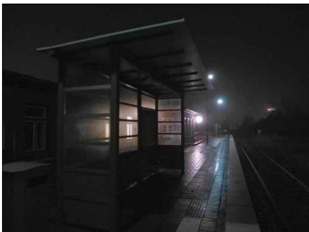
Abbildung 3: Erneut war die Beleuchtung im Unterstand und in der Vitrine auf dem Bahnsteig in Hademarschen nicht funktionsfähig.
