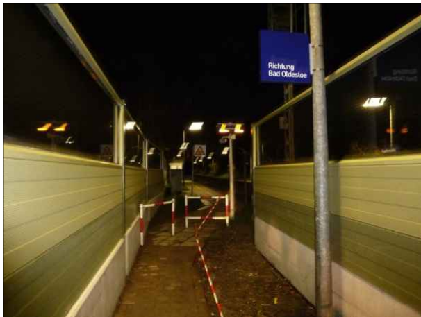
Abbildung 43: Die neu errichteten Lärmschutzwände schränken die Zugangsbreite an Gleis 2 des Haltepunkts Kupfermühle ein.
