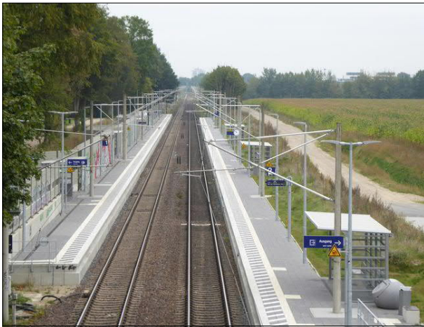
Abbildung 6: Die im Dezember 2023 eröffnete Bahnstation Lübeck-Moisling mit zwei Außenbahnsteigen an der Strecke Lübeck - Hamburg.
