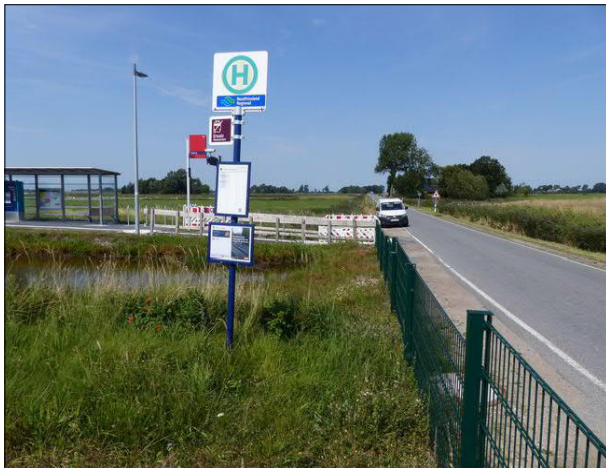
Abbildung 37: Bei der Neuanlage des Bahnsteigzugangs in Kating wurde der Bushaltestellenmast eingezäunt. Die Aushänge daran sind nun nicht mehr erreichbar.
