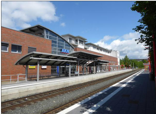
Abbildung 2: Die Bahnsteige in Quickborn wurden bereits mit der Höhe für den künftigen S-Bahn-Betrieb erneuert. Für weitere Bauarbeiten wird dort allerdings bis September 2025 kein Zug mehr fahren.
