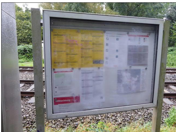
Abbildung 23: Die Vitrinenscheibe in Krempe am Zugang zu Gleis 2 ist aus Kunststoff. Bei allen Erhebungen war sie flächig trüb, so dass die Aushänge nicht lesbar waren.
