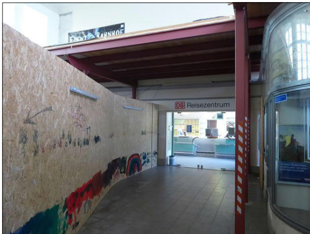
Abbildung 31: Die Empfangshalle in Schleswig ist seit dem Frühjahr 2024 nur noch von der Straßenseite aus zugänglich. Der Weg führt entlang des provisorischen Holzzauns zum Reisezentrum.
