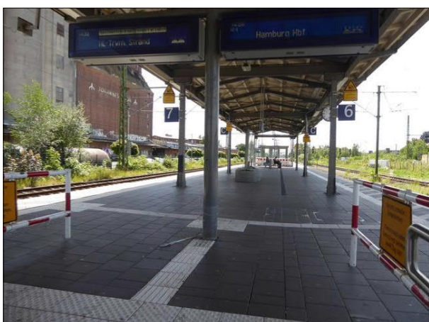
Abbildung 11: Auf dem Bahnsteig der Gleise 6/7 in Bad Oldesloe führt der Blindenleitstreifen von einem Treppenaufgang direkt auf den Mast der Zugzielanzeiger.
