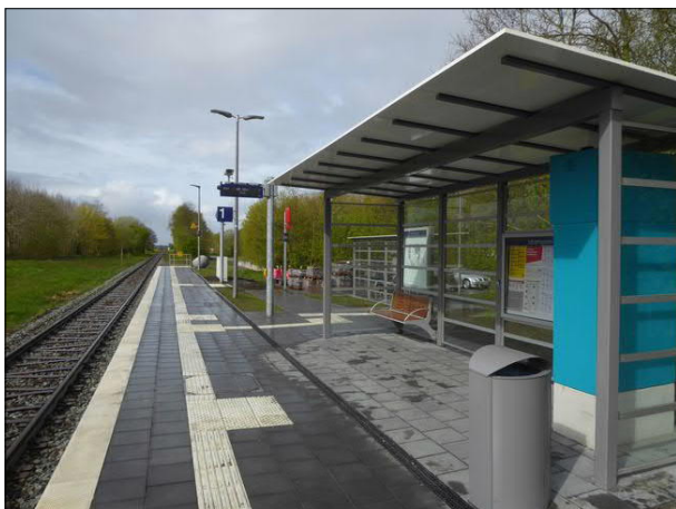
Abbildung 40: Nach mehrmonatiger Sperrung mit dem Neubau fast aller Bahnsteige fahren seit April 2024 wieder Züge von Husum nach Bad St. Peter-Ording. Hier ist der neue Bahnsteig in Tating zu sehen.
