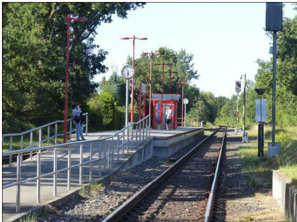
Abbildung 39: Der Bahnhof Boostedt wies bei allen Erhebungen nur kleine Mängel auf. In zwei Quartalen erhielt er die Gesamtnote „sehr gut“.
