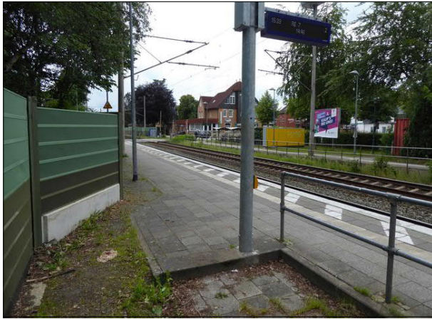
Abbildung 21: Der neue Schriftanzeiger in Einfeld an Gleis 2 steht direkt an der Stufe eines Zugangs zu einem Schalthaus. Für Sehbehinderte, die den Taster für die akustische Information drücken möchten, kann das unnötig gefährlich werden.
