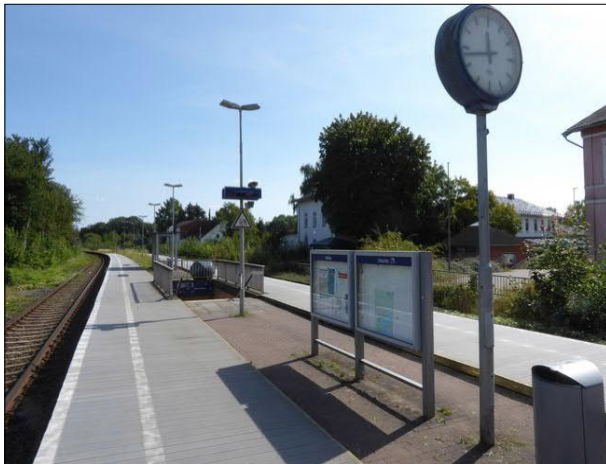
Abbildung 1: In Asheberg wurde an beiden Gleisen durch Holzaufbauten eine Bahnsteighöhe von 55 cm über der Schienenoberkante erreicht, um den Ein- und Ausstieg in die neuen Akkutriebwagen zu ermöglichen.
