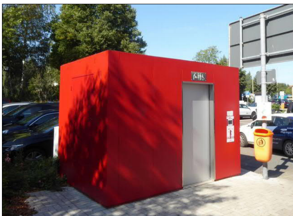
Abbildung 35: In Süderbrarup wurde neben dem Bahnhofsvorplatz eine Toilettenanlage aufgestellt. Diese steht rund um die Uhr gegen eine Gebühr von 50 ct zur Nutzung bereit.
