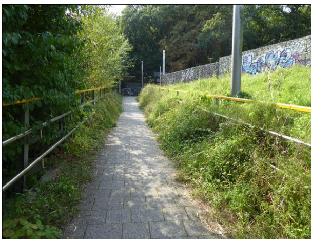
Abbildung 17: Im Sommer waren die Ränder der Rampe zu Gleis 1 in Ahrensburg-Gartenholz einschließlich der Handläufe stark zugewuchert. Im Gegensatz zu anderen Stationen waren die Sträucher in Gartenholz aber dornenfrei.
